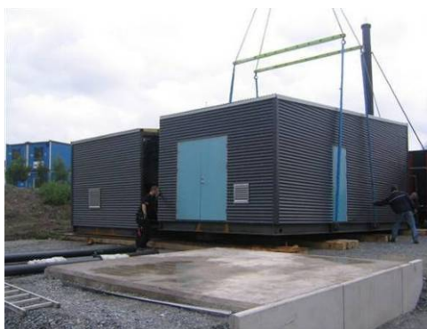
Montering av prefabrikkert bioenergicentral (foto SWECO Grøner AS)
