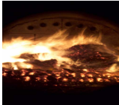
Brennkammer (foto SWECO Grøner AS)
