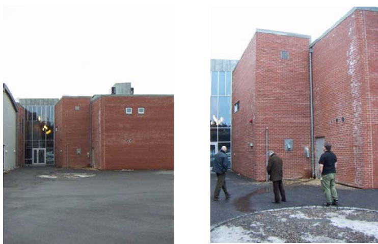
Eksempel på bioenergisentral med pelletsilo, Re skole, Larvik kommune (Sweco Grøner AS)
