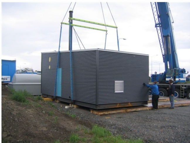
Prefabrikkerte bioenergisentral under montering (foto SWECO Grøner AS)
