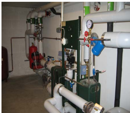
Kundesentral (foto: Energi & Miljøteknikk AS, SGP VARMETEKNIKK AS)
