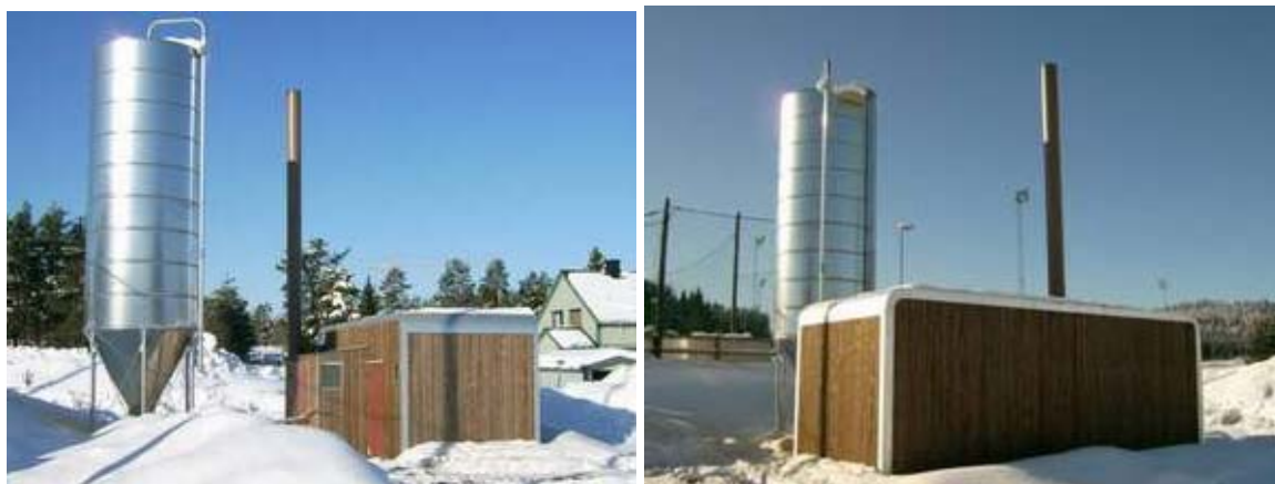
Eksempel på bioenergisentral med pelletssilo (Morgan AS)
