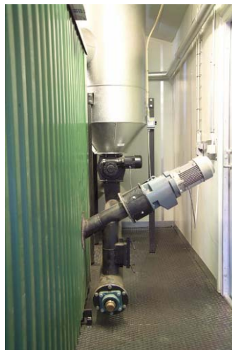
Askeutmating og multisyklon (foto SWECO Grøner AS)
