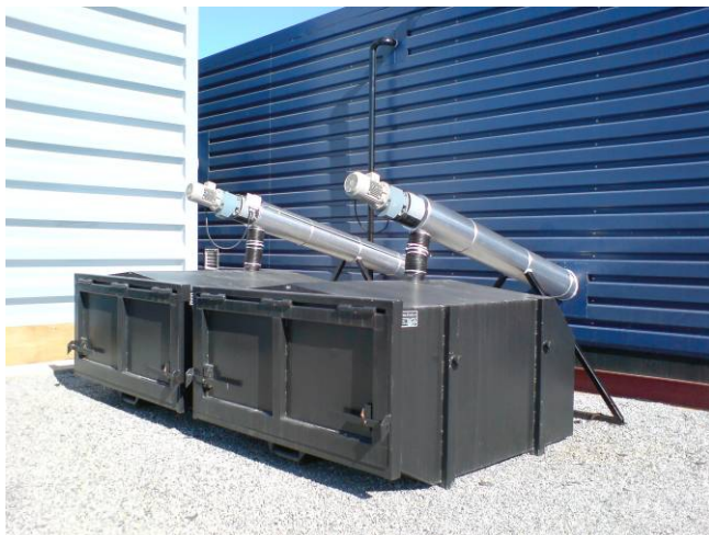
Askeutmating og multisyklon (foto SWECO Grøner AS)
