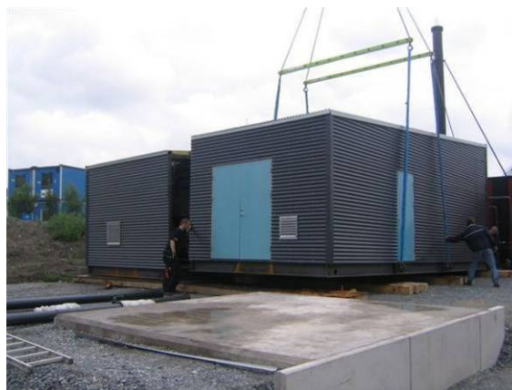
Montering av prefabrikkert bioenergisentral (foto SWECO Grøner AS)
